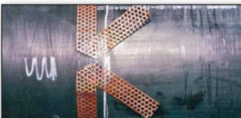
16. Izmeriti potrebnu dužinu kompenzacione trake od butil-kaučuka (17+28/43) i na rastojanju od 30 mm pored bakarne trake obaviti oko obložne cevi. Pustiti da se krajevi preklapaju oko 50 mm u 12:00-časova položaju.
