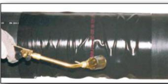
12. Izmeriti potrebnu dimenziju zaptivne trake od butil-kaučuka (17) i radijalno obmotati oko oba ruba termoskupljajuće folije, odnosno oko obložne cevi, tako da se u 12:00 poziciji preklapa oko 50 mm.
