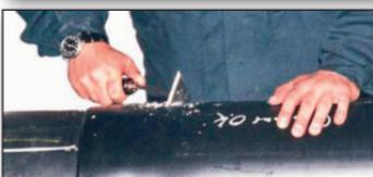
29. Sada bi trebalo jedan PE-čep i probušeni otvor zagrejati aparatom za zavarivanje čepova (6).
