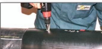
18. Sadase spojnicapodvrgava ispitivanju zaptivenosti pomoću vazduha pod pritiskom od 0,3 bara (1). Na spojeve krajeva spojnice i plastičnih omotača cevi nanosi se sapunjava voda (35). Posle toga sprati sapunjavu vodu (20+22).
