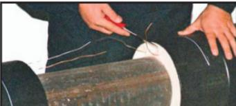
5. Pripremiti povezivanje žica: krajeve žica treba pažljivo ispraviti (46). Kod **IPS-Cu-a** treba skratiti, odmastitи i očistiti šmirgl-papirom (29).
