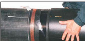
19. Izbušiti **jedan** otvor za evakuisanje vazduha, Ø 10 mm, na jednom kraju spojnice (5/26+6).
