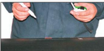
18. Obeležiti položaj kontrolnih žica na obložnoj cevi (16). Tako se tokom dalje montaže spojnice sprečava oštećenje žica, na primer, prilikom bušenja rupa za punjenje penom.
