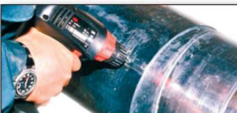
17. Na spojnici treba na 12:00 časova poziciju izmeriti (17) i obeležiti (16), a zatim izbušiti mesta za otvore za odzračivanje prečnika 4 mm (5+6). Da bi se postigla dobro odzračivanje spojnice i da bi se izbegla pojava mehura gasa, otvor treba planirati što bliže ivici spojnice. Kod golih cevnih završetaka dužine 200 mm, bušotine treba pozicionirati 175 mm od ivice spojnice ka sredini.
