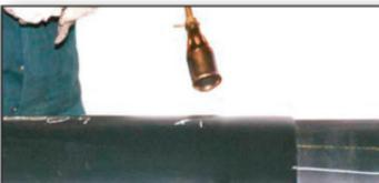
17. Na 20 mm označenom mestu izbušiti otvor prečnika 10 mm (6+26).
