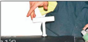
31. Nakon što je drugi čep postavljen isto kao i prvi (29. i 30.), prelazna područja između spojnica i obložne cevi treba temeljno očistiti sredstvom za čišćenje PE-a (20+22), i to na oba prelaza po oko 300 mm (17), to jest, 150 mm na spojnici i 150 mm na obložnoj cevi.
