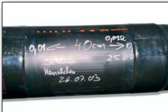
Ove oznake omogućavaju identifikovanje montera koji je izvršio obradu mesta spajanja cevi, čime se obezbeđuje viši kvalitet izvedenih radova. Ukoliko obrada spojeva treba da bude izvedena od strane neke treće firme, sposobljenost montera te firme treba provjeriti pre otpočinjanja radova traženjem da se podnesu na uvid njihovi BFW-sertifikati. Ovo predstavlja izuzetak koji mora da bude odobren od strane inženjera firme **Isoplus**.
