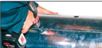
15. Uzdužni šav preklapajućeg lima spojnice fiksirati, odnosno spojiti (18) pop-nitnama.
