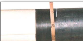
10. Zatim treba sa PE-termoskupljajuće spojnice skinuti zaštitnu foliju, a onda se folija mora zategnuti i centrirano obaviti oko zone spajanja.
