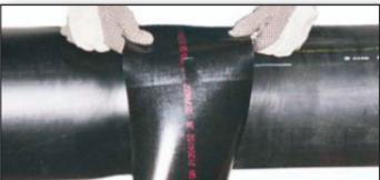
36. Sa drugog pravog kraja koji se preklapa otkloniti zaštitnu foliju sa integrisane film trake za zatvaranje.
