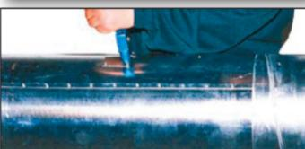
Kao alternativa i u slučaju potrebe, kod aluminijumske i spiro-spojnice kao prave spojnice i do prečnika obložne cevi od 250 mm postoji mogućnost da se izolacija izvrši pomoću dvodelne PUR-polutke kao i prvo zaptivanje pomoću PE-termoskupljujuće folije.
